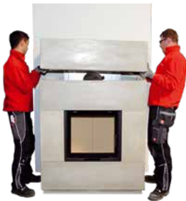
12. Mittelteil (nur bei S7 Hoch!) ohne zu verkleben auf das Oberteil setzen.
