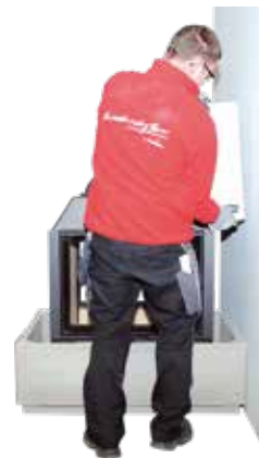
7. Erstes Seitenteil ohne zu verkleben gleichmäßig auf die Unterteile setzen und ausrichten.
