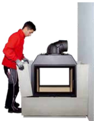
8. Zweites Seitenteil ohne zu verkleben gleichmäßig auf die Unterteile setzen und ausrichten.
