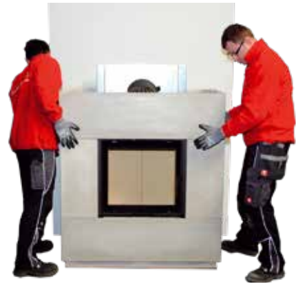
11. Oberteil ohne zu verkleben auf die Seitenteile setzen und ausrichten.
