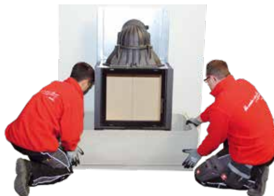
7. Vorderes Unterteil ohne zu verkleben auf die Bodenplatte setzen und ausrichten.
