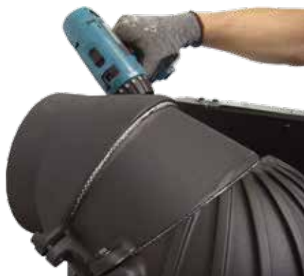
6. Abgaskuppel für waagerechten Anschluss montieren.
