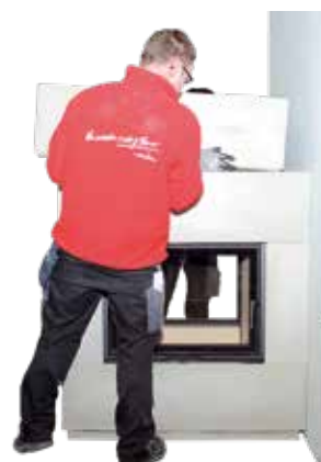
11. Mittelteil (nur bei S7 TV Hoch!) ohne zu verkleben auf das Oberteil setzen.
