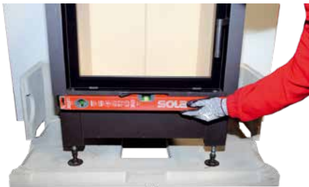
4. Kamineinsatz mit Wasserwaage ausrichten.
