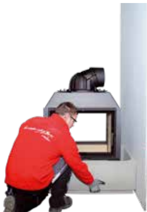
6. Vorderes Unterteil ohne zu verkleben auf die Bodenplatte setzen.
