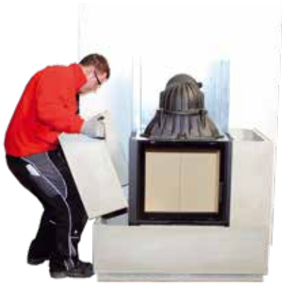
10. Zweites Seitenteil ohne zu verkleben auf das Unterteil setzen.
