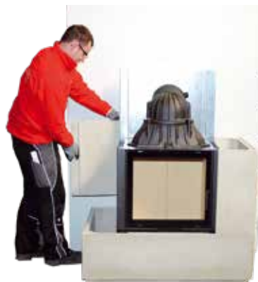
9. Rückwandmodul ohne zu verkleben auf das Unterteil und vor das Seitenteil setzen.
