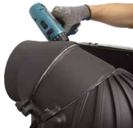
9. Abgaskuppel für waagerechten Anschluss montieren
