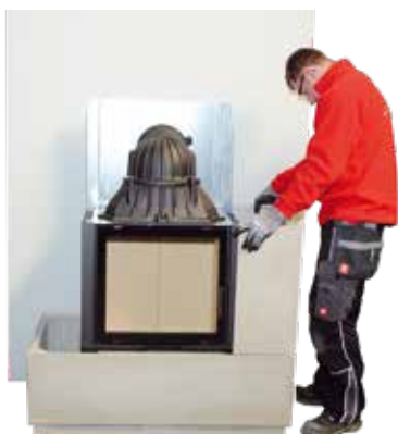
8. Erstes Seitenteil ohne zu verkleben auf das Unterteil setzen.
