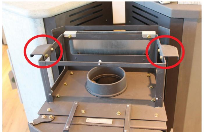
Stellen Sie die Seitenteile mit der Nut auf den halbkreisförmigen Steinhalter unten am Korpus und befestigen Sie den Steinhalter oben wieder. Die Aussparung an der Oberseite zeigt zur Korpusmitte.
