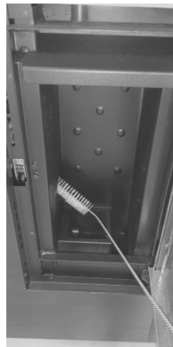
Fig. 36 - Reinigung mit Flaschenbürste
