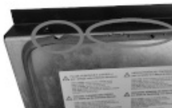
Fig. 27 - Verschlechterte Dichtung
