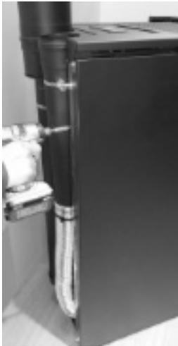
*Fig. 22 - Hintere Schrauben abschrauben*
