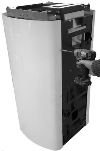
**Fig. 44 - Hintere Schrauben entfernen**
