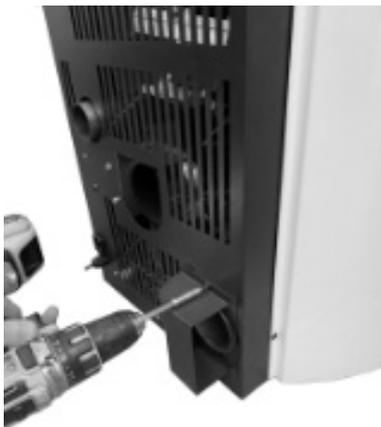
*Fig. 65 - Umlenkblech entfernen*
