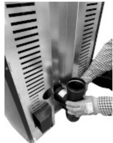
*Fig. 53 - T-Anschlussstück anschließen*
