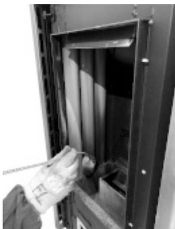
*Fig. 91 - Mit einer Rohrreinigungsbürste reinigen*
