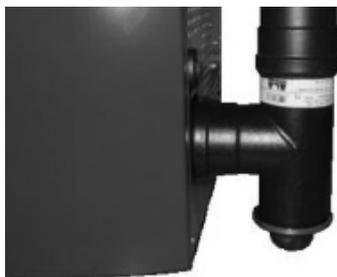
**Fig. 85 - Reinigung des Rauchgaskanals**
