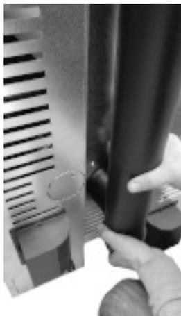
**Fig. 58 - Rohr Durchm. 80 mm einstecken**
