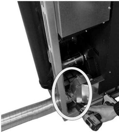
**Fig. 68 - Schlauch sichern**
