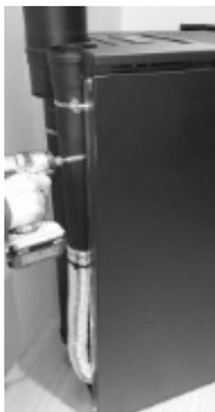
*Fig. 32 - Hintere Schrauben entfernen*
