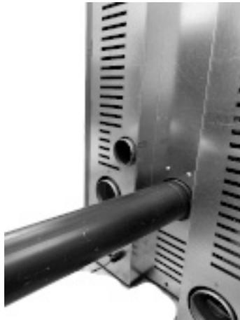
*Fig. 50 - Anschluss des Rauchgasauslasses*
