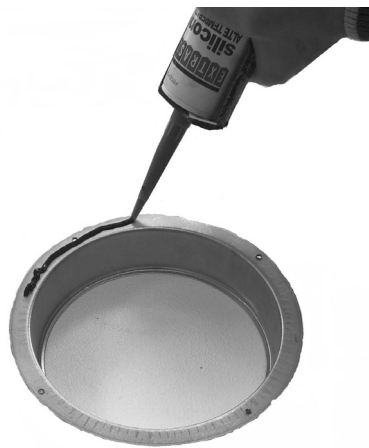
Fig. 66 - Silikon den Flansch
