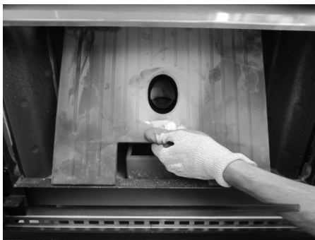
Fig. 110 - Entfernung der mittleren Wand aus Gusseisen
