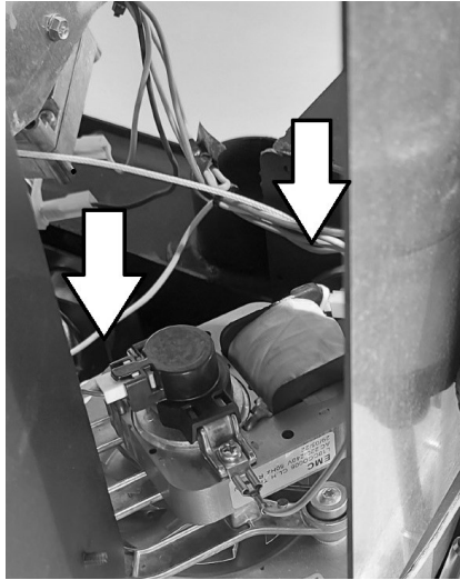
Fig. 98 - Die Schrauben entfernen - Reinigung 1
