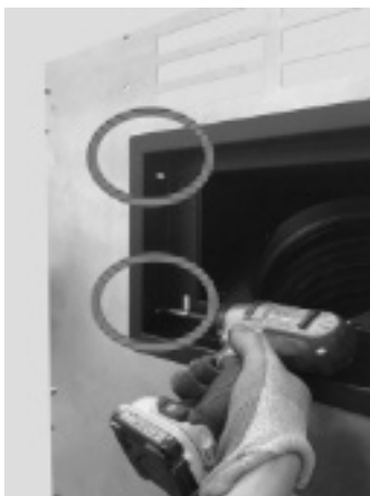
Fig. 68 - Befestigung Ladeklappe außen
