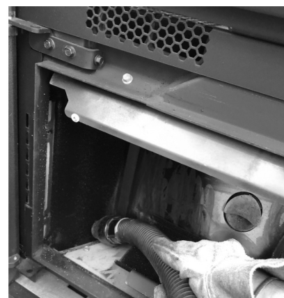
Fig. 106 - Die Asche absaugen
