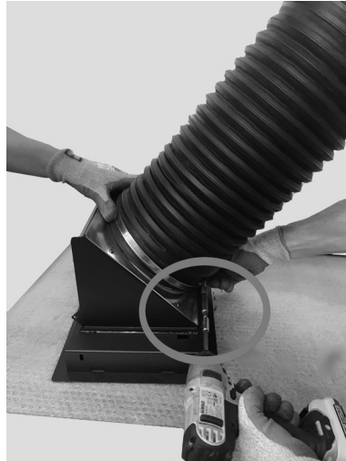
Fig. 63 - Schellen festziehen
